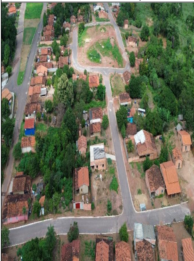
FOTO 05- Não existência do evento 3 calçadas
