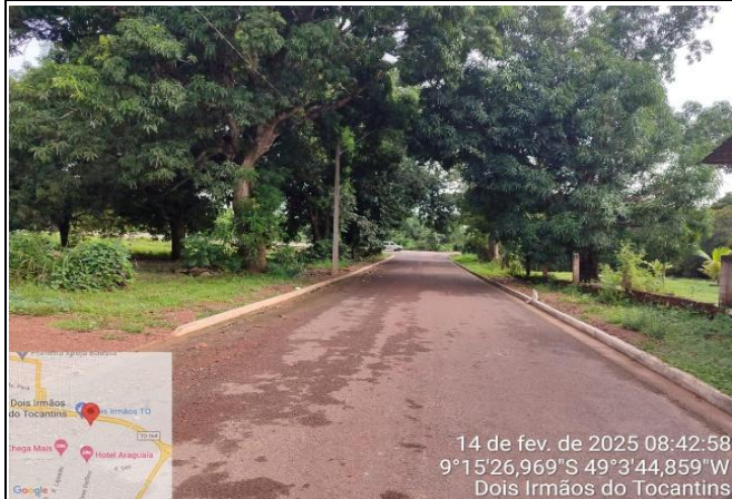
FOTO 05- Não existência do evento 3 calçadas
