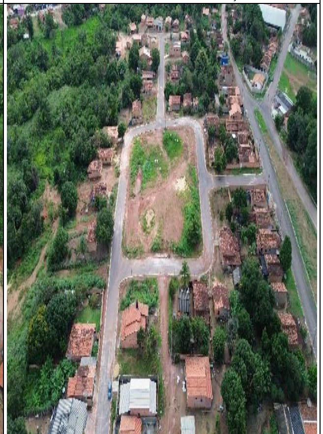
FOTO 6- Não existência do evento 3 calçadas
