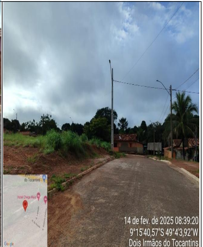
FOTO 04- Não existência do evento 3 calçadas
